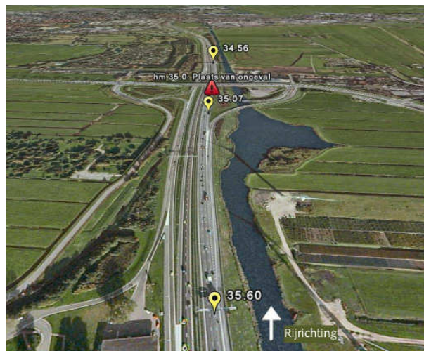
Figuur 4.17: Overzicht geselecteerde wegversmalling
